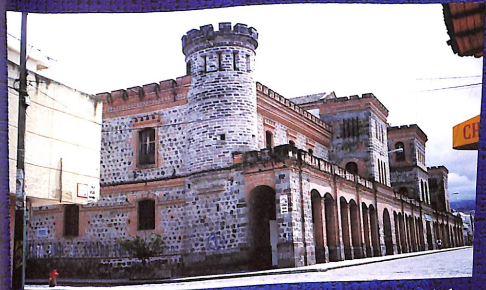
Antiguo edificio del Cuartel Militar de la ciudad de Ibarra, junto al parque Víctor Manuel Peñaherrera. (Foto cortesía de F. Yépez Almeida).
